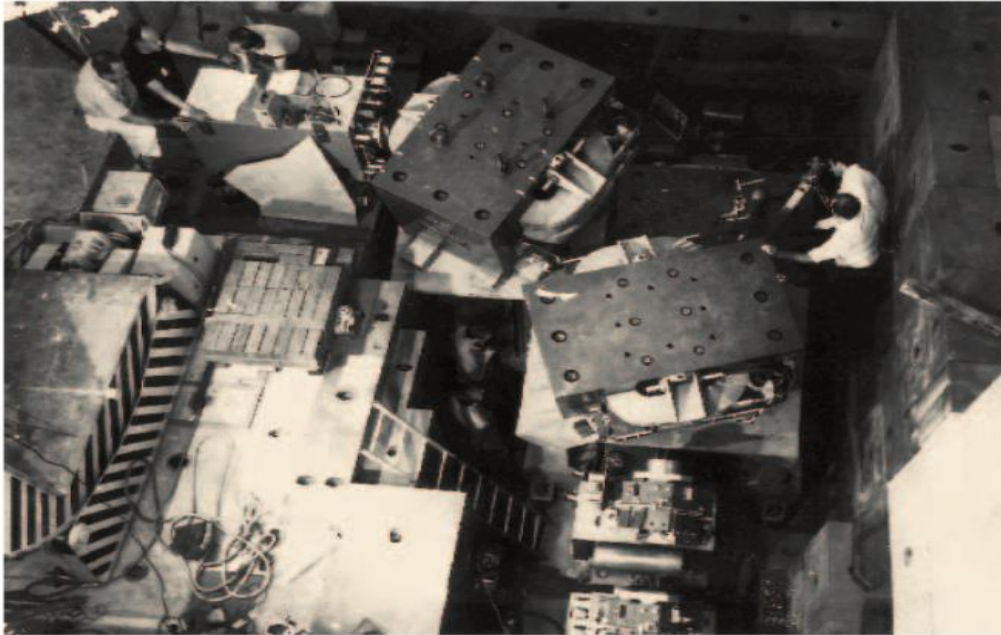
Der 10 Meter kurze Kaonstrahl, aufgebaut auf einer 30 Grad schiefen Ebene
